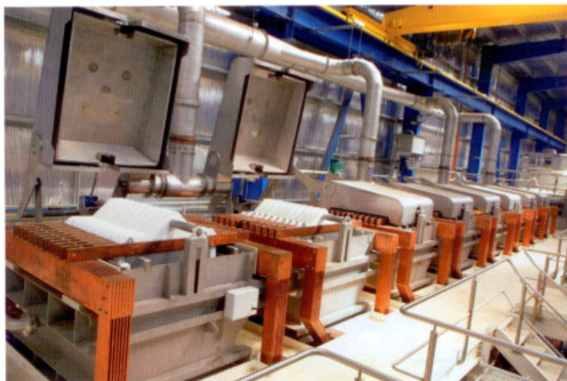
Blick in die Rückgewinnungsanlage von Zink bei CMA, Melbourne.
